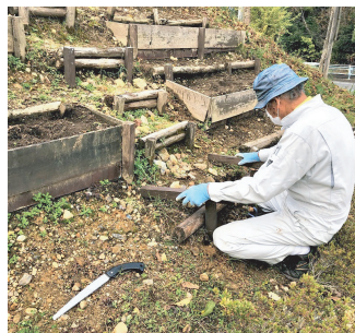
最近は階段部の腐食が特に目立ち、修繕が必須
